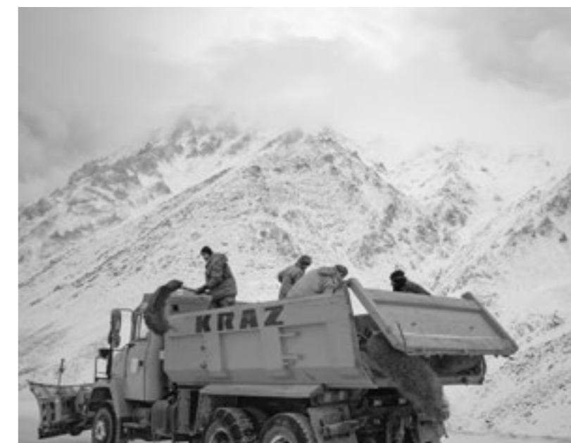
Auf die vereiste Straße wird Sand geschaufelt
