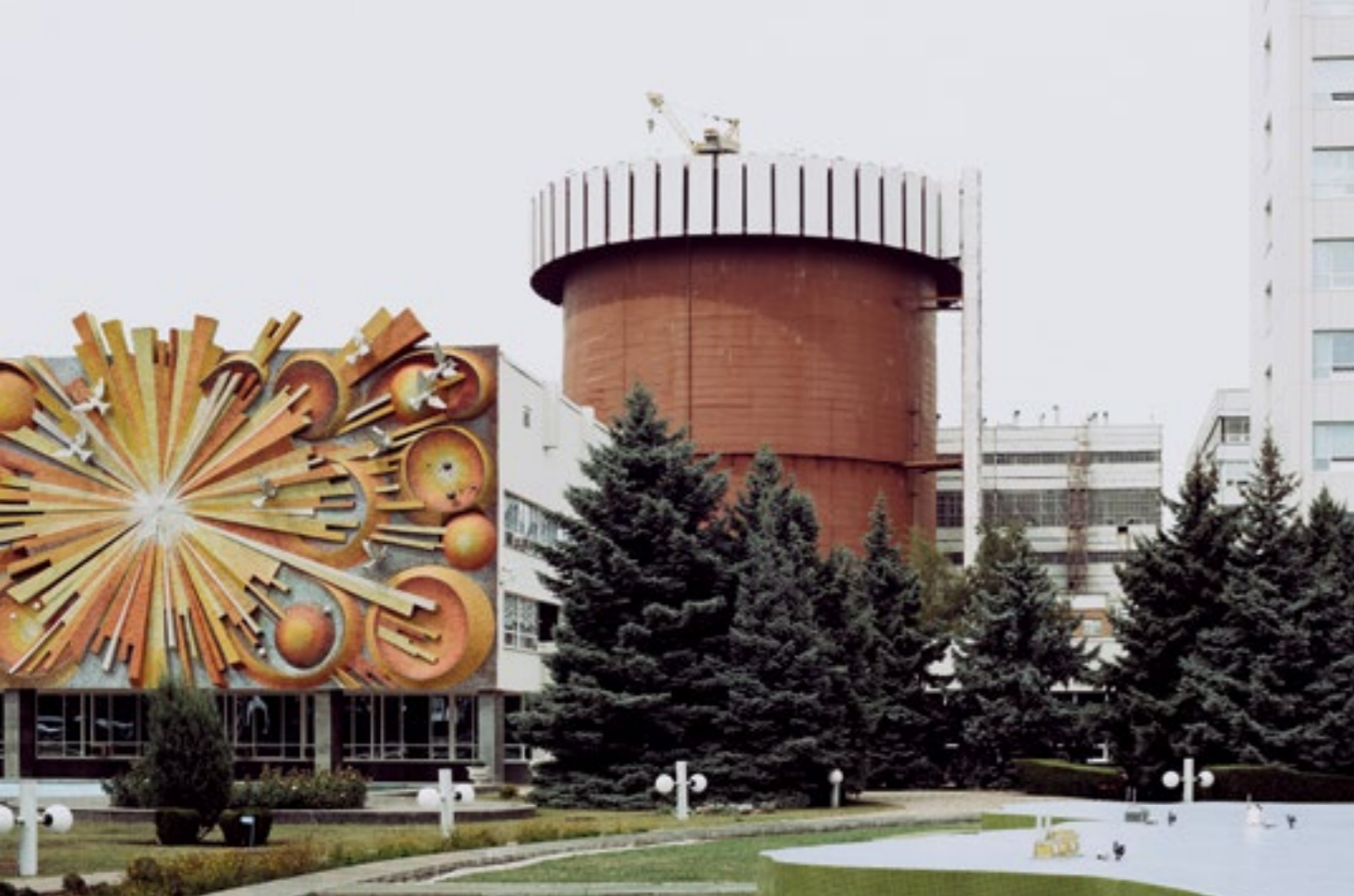
Einer der Reaktoren steht hinter den Bürogebäuden des AKW
